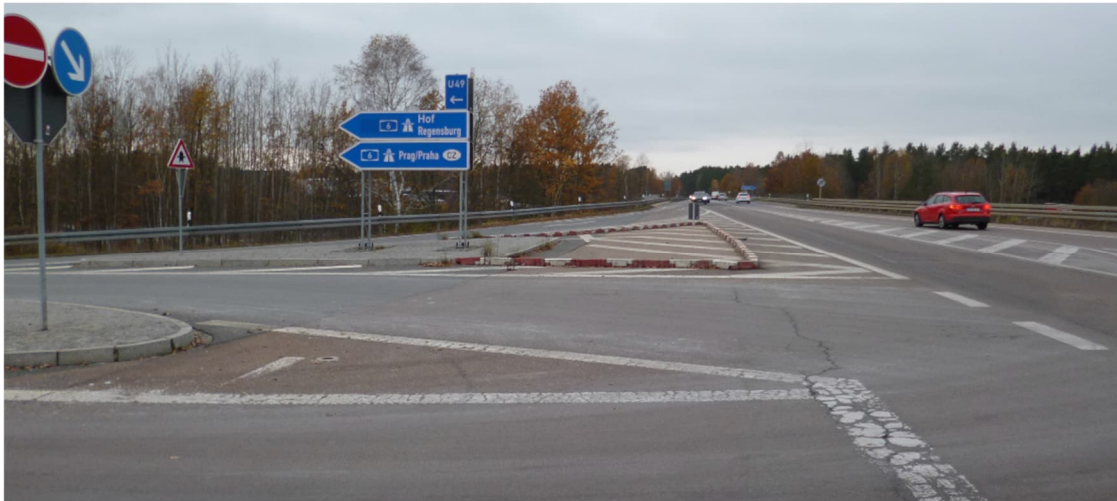
Bild 14: Einmündung der Verbindungsrampen in die B 85 (AS Amberg-Ost, Südostseite), provisorische Inselerweiterung
