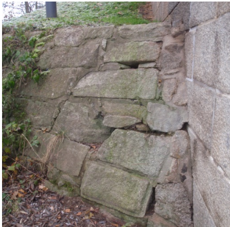
Foto.: 1 Spaltenquartiere am Widerlager Ost
