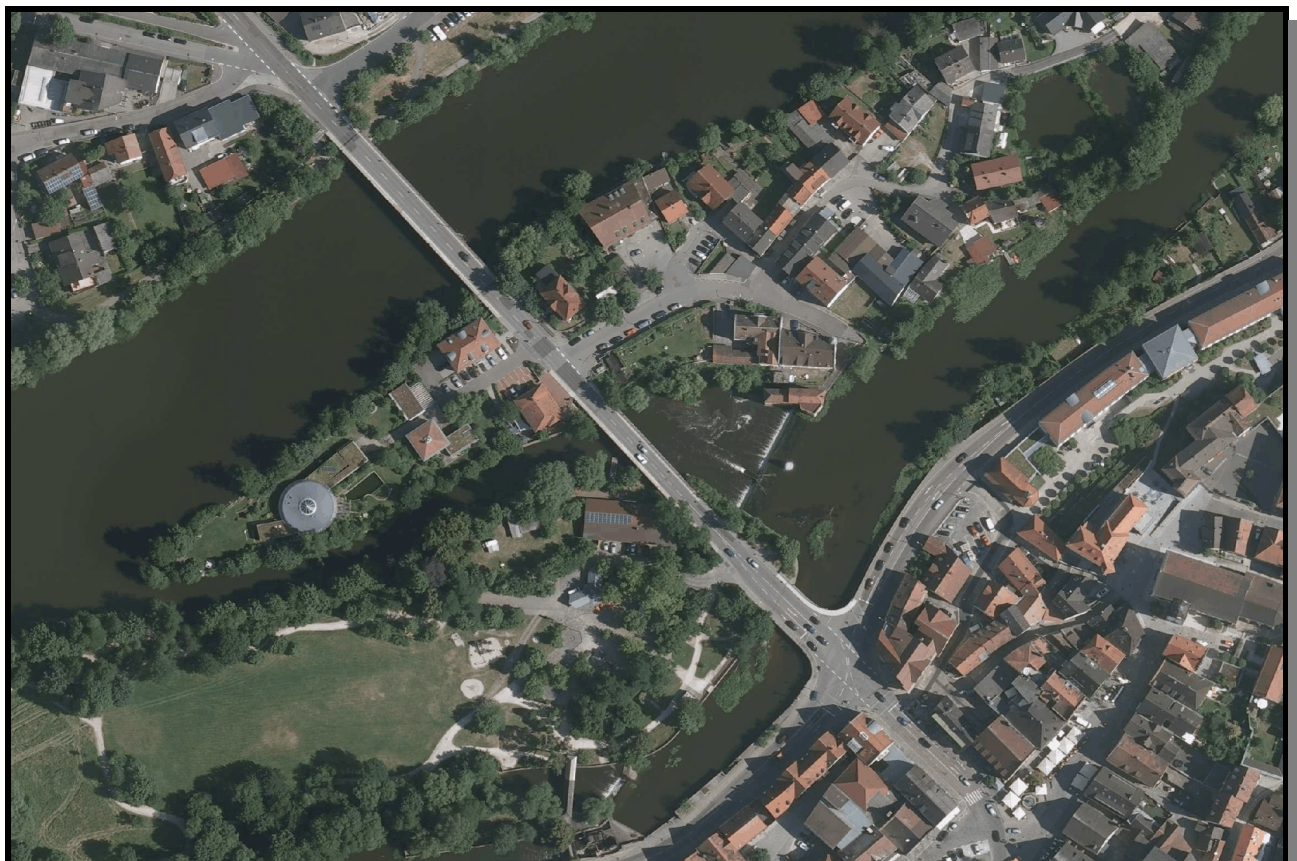
Luftbild der Naabbrücken im IST-Zustand
