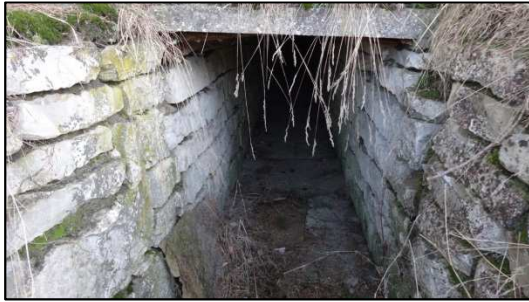
Abb. 5: Baudenkmal angrenzend an den Eingriffsbereich
