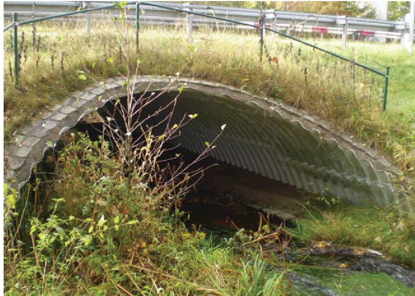
Abb. 2: Bestehender Durchlass am Hohlbach, Hüttener Straße
