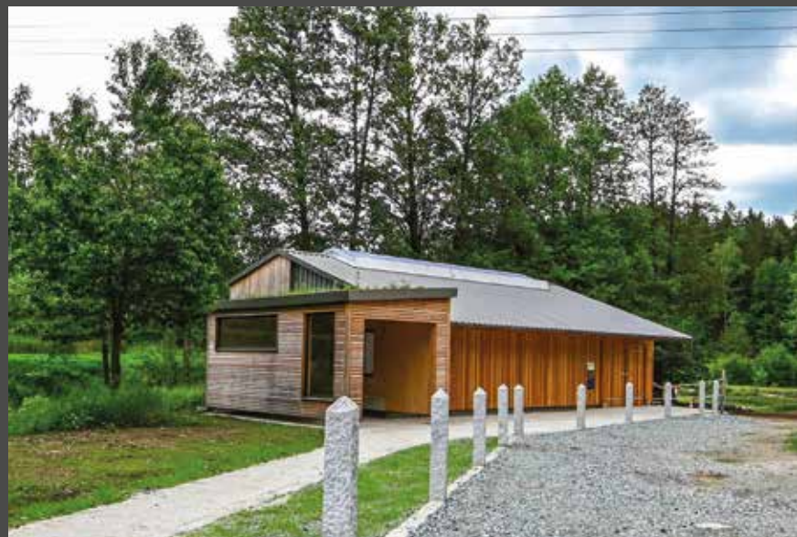
Stanice pro odchov mladých jedinců perlorodky v informačním centru Grenzmühle
