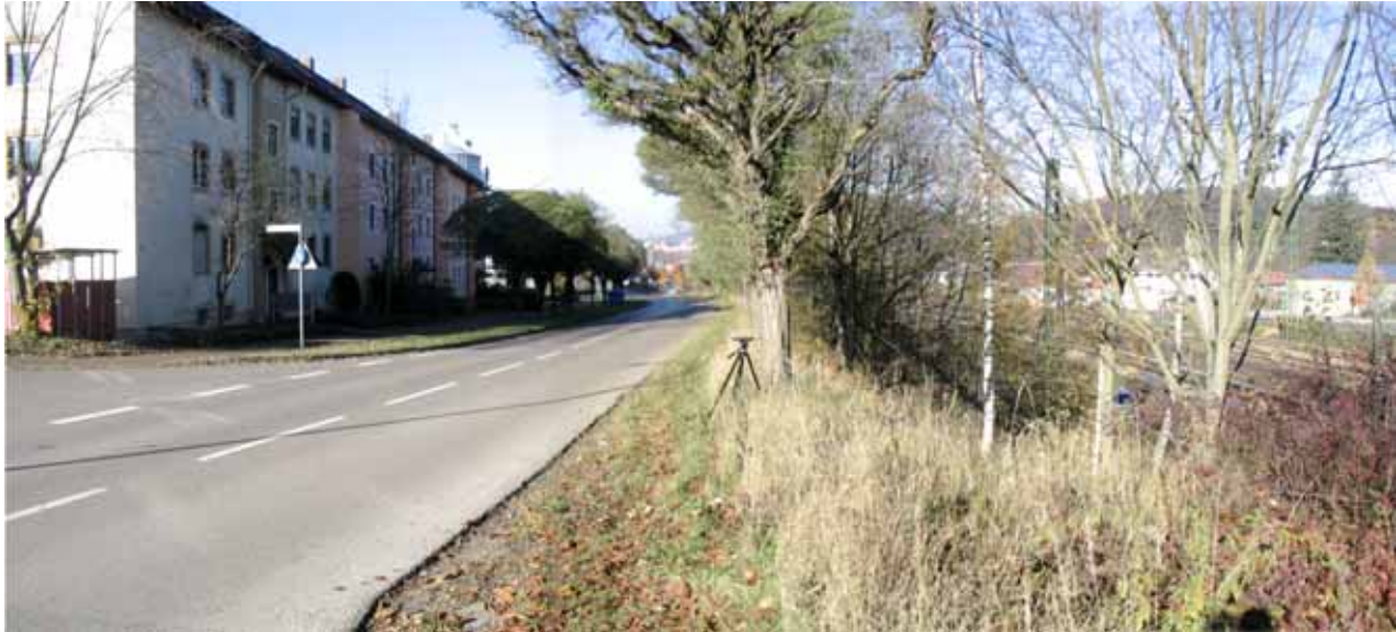
Aufnahme vom nordöstlichen Rand Parsbergs in der Bahnhofstraße – Abzweigung Schulzentrum / Kreiskrankenhaus. Quelle: Regierung der Oberpfalz, Aufnahme vom 05.11.2008
